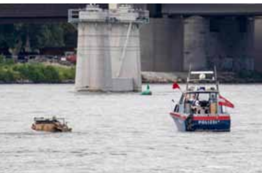
Franz Prechtel gibt mittels Flagge dem Amphibienfahrzeug, das stromabwärts auf Höhe der Brückenbaustelle unterwegs war, das Zeichen zur Anhaltung.
