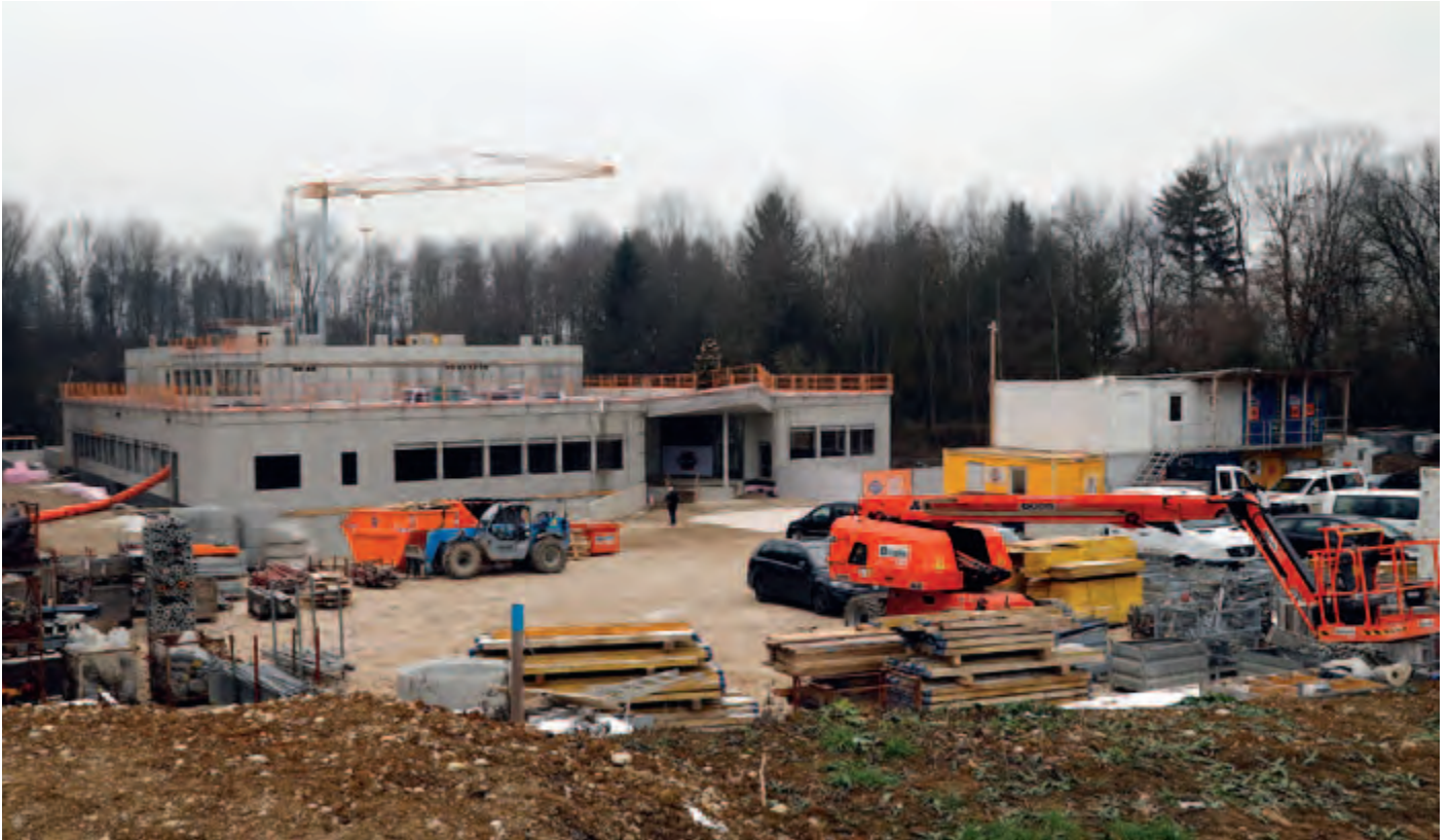
Der Rohbau steht – Schritt für Schritt entsteht das neue ETZ.
