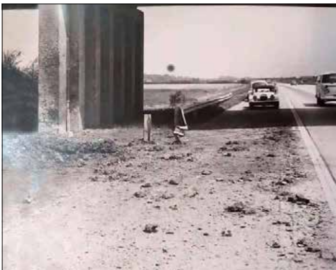
Sprengkrater unter der Autobahn
